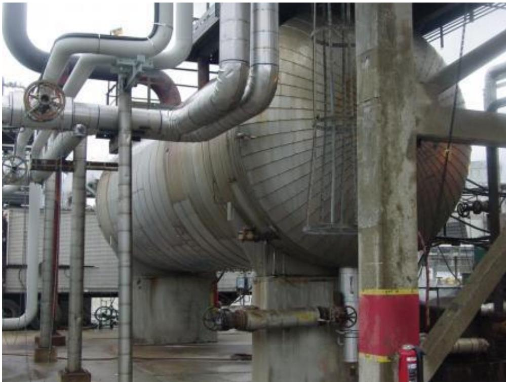
在重力分离的第一阶段，并不是所有的水都从原油中分离出来。分离后的原油含水量可能依旧高达 15%，并处于乳化状态，很难再分离出来。使用化学试剂和加热完成去乳化过程，消除油和水的乳化状态，以便在运输原油之前将水分去除。
